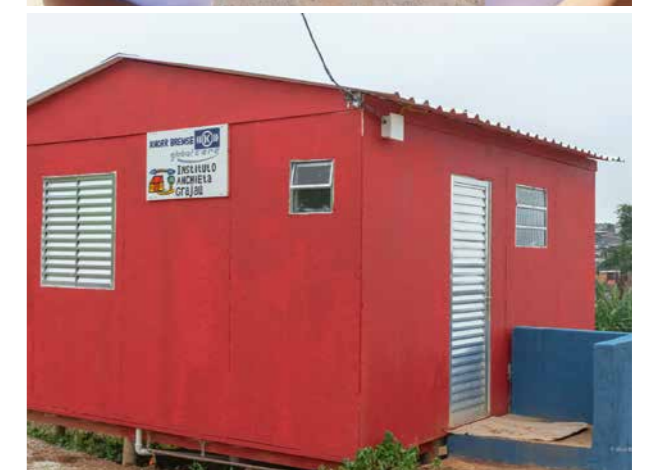
Mit einer Ausbildung zur Baufachkraft werden Favela-Bewohner in São Paulo zum eigenen Hausbau befähigt.
